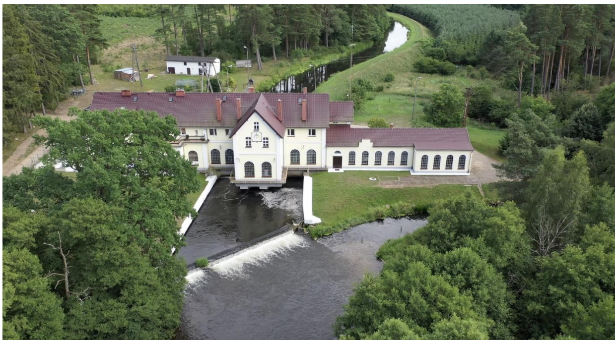
Elektrownia Wodna Żelkowo
