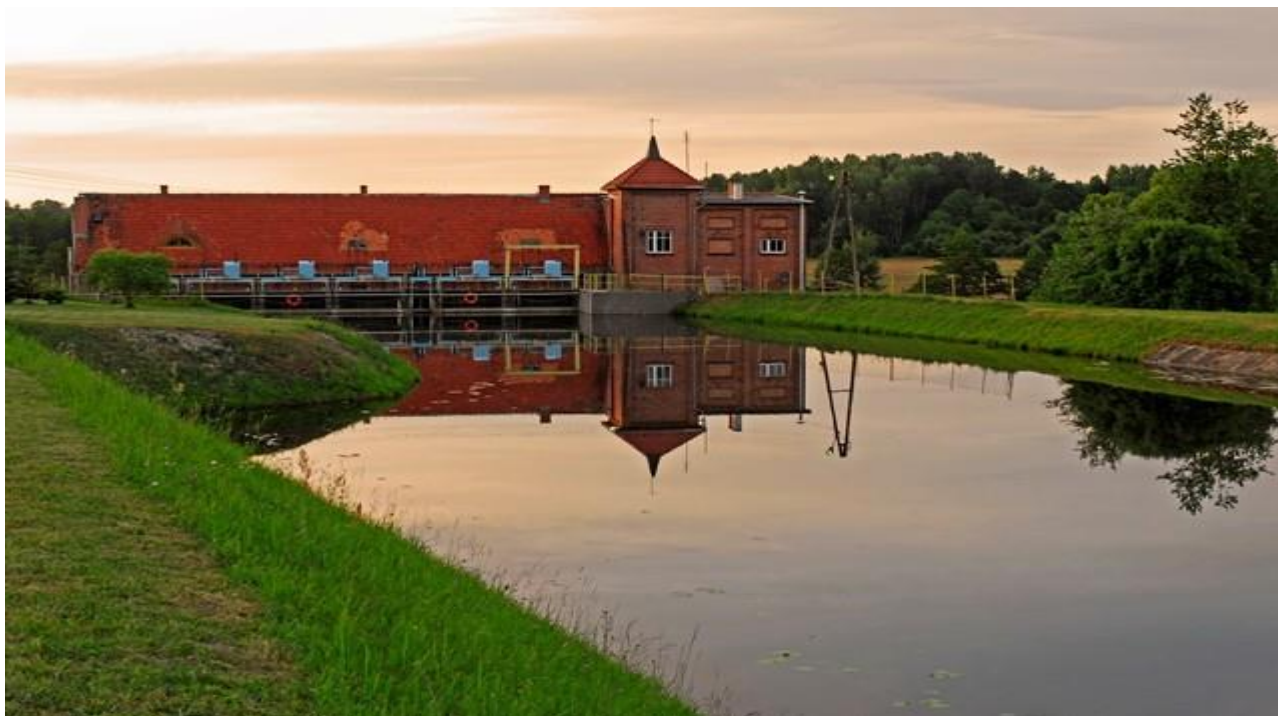
Elektrownia Wodna Pierzchały
