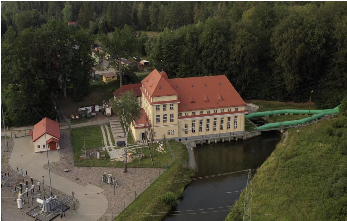
Hydro power plant in Gałąźnia Mała on the Słupia river
