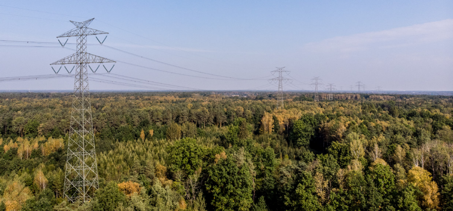
PSE, Słupy nadleśne PSE w znaczący sposób ograniczają wycinkę lasu.
