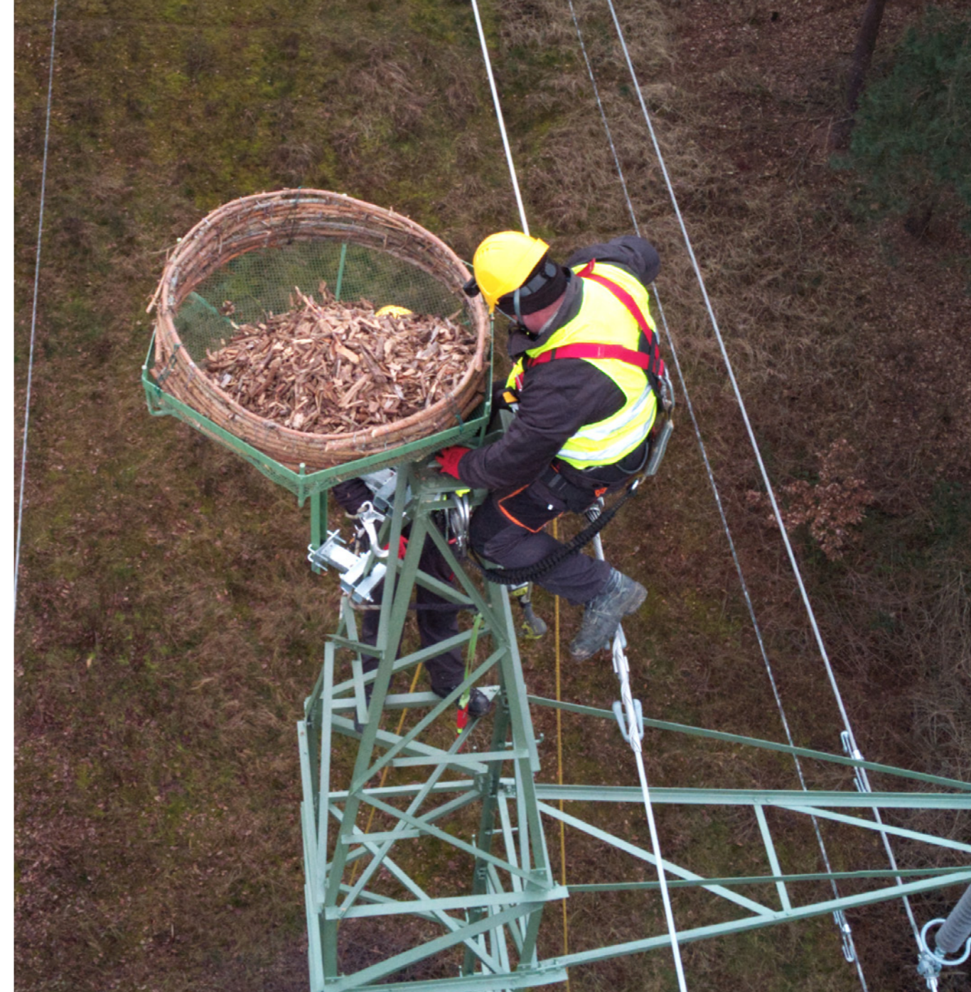
Enea Operator, Montaż platformy pod gniazdo rybołowa
