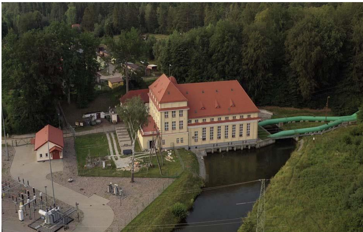
Elektrownia wodna w Gałąźni Małej na rzece Słupia
