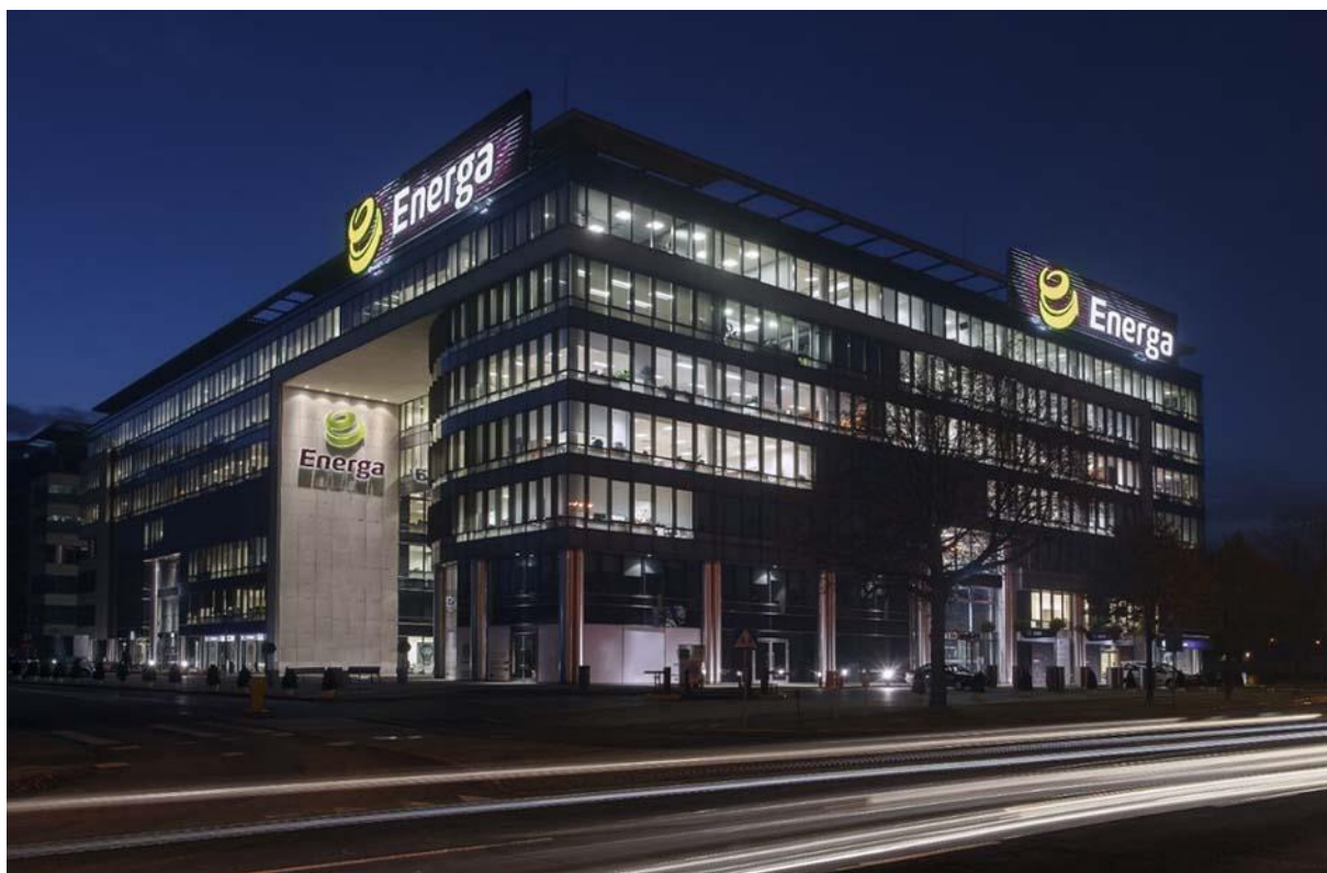
Siedziba Spółki Energa SA w Gdańsku przy al. Grunwaldzkiej
